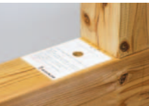
1. 座金を設置する材面に ビス打ち用シールを貼ります。
