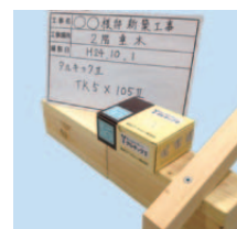
施工の確認用として写真等で記録することをお薦めします。
